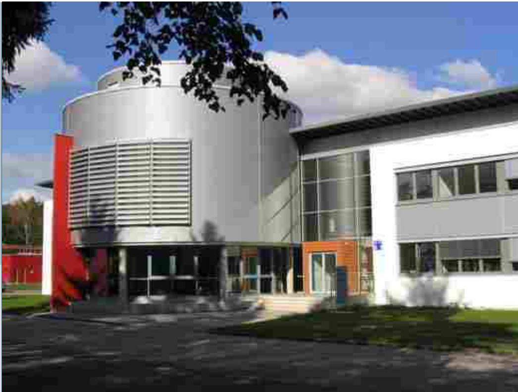
Supercomputing Centre Jülich (JSC)
