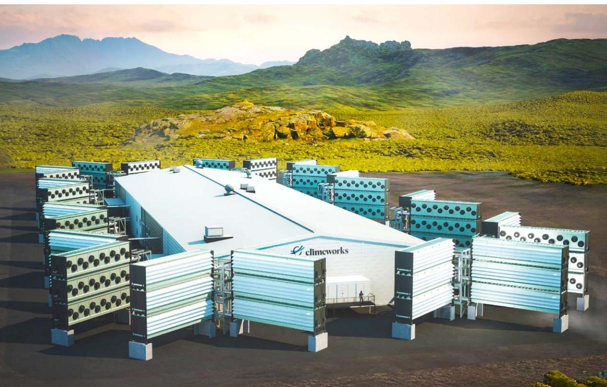
← Die Kollektoren, welche das CO<sub>2</sub> aus der Luft filtern, stecken bei der Mammoth-Anlage in großen Containern. Im Vollbetrieb wird es 72 Container geben.
