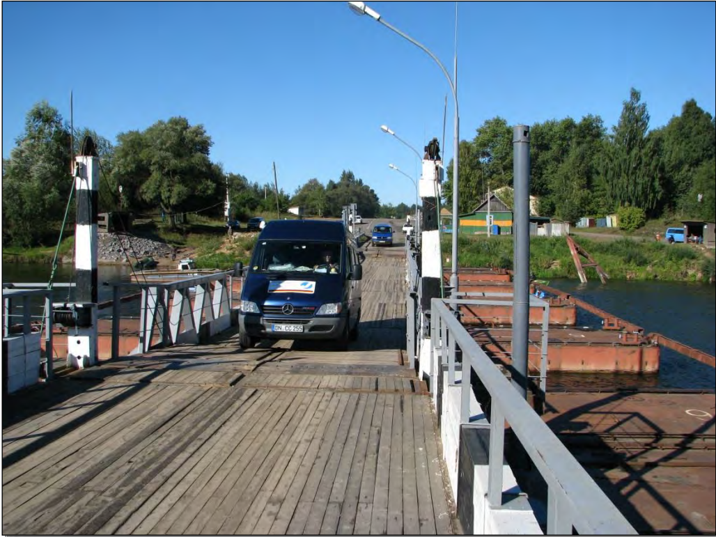
Foto 3 : Neue Pontonbrücke über die Sosch auf der Strecke von Korma nach Volincy (2013)
