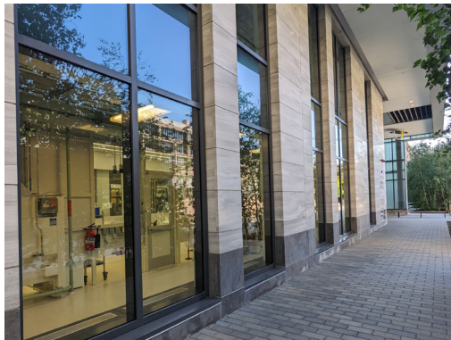
Reinraumgebäude des MIT
