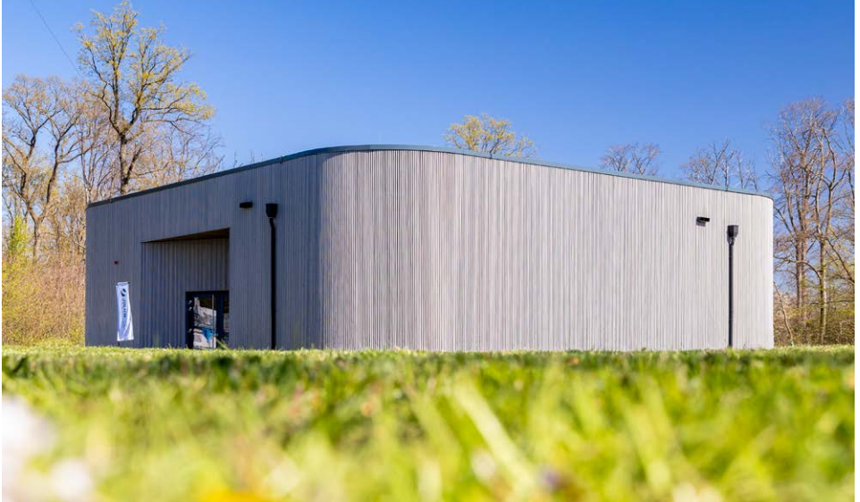
Das Gebäude der JÜelicher Nutzer-Infrastruktur für Quantencomputing (JUNIQ)
